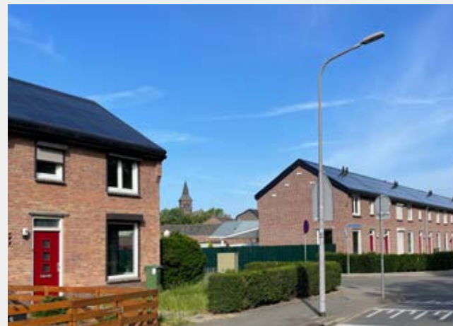
Geïntegreerde pv-panelen op zadeldaken
