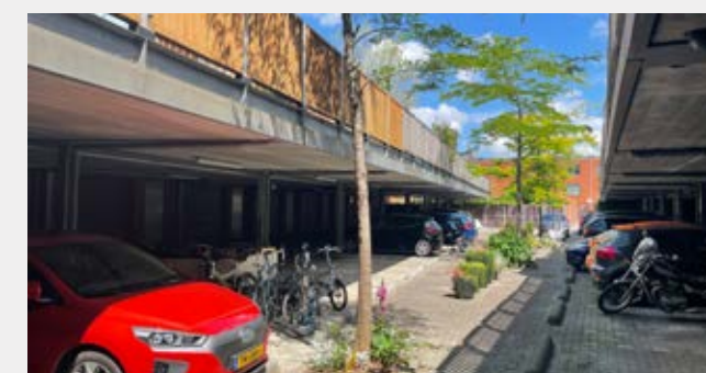
Een halfverdiepte gebouwde parkeeroplossing
