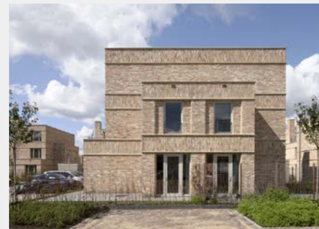
Strijp-R Eindhoven Architect: HCVA
