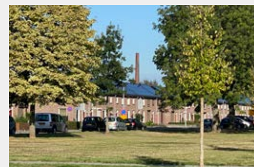
4. Zinkwitschoorsteen vanaf Balijeweg
