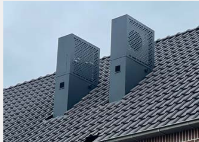
Geïntegreerde warmtepomp als schoorsteen
