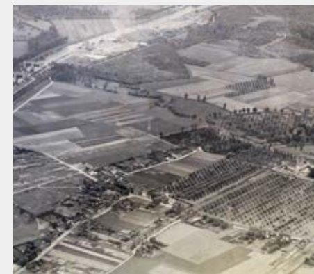
Tussen 1902 tot 2008 werd op het zuidelijke fabrieksterrein, Sphinx tegels, keramische vloeren en wandtegels geproduceerd
